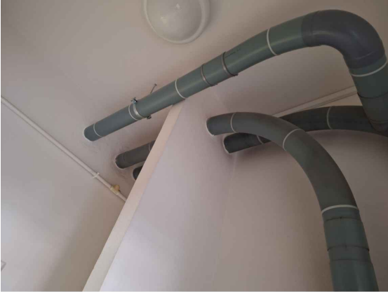
STÁVAJÍCÍ VEDENÍ POTRUBNÍ POŠTY A STANICE, MÍSTNOST A2.16
